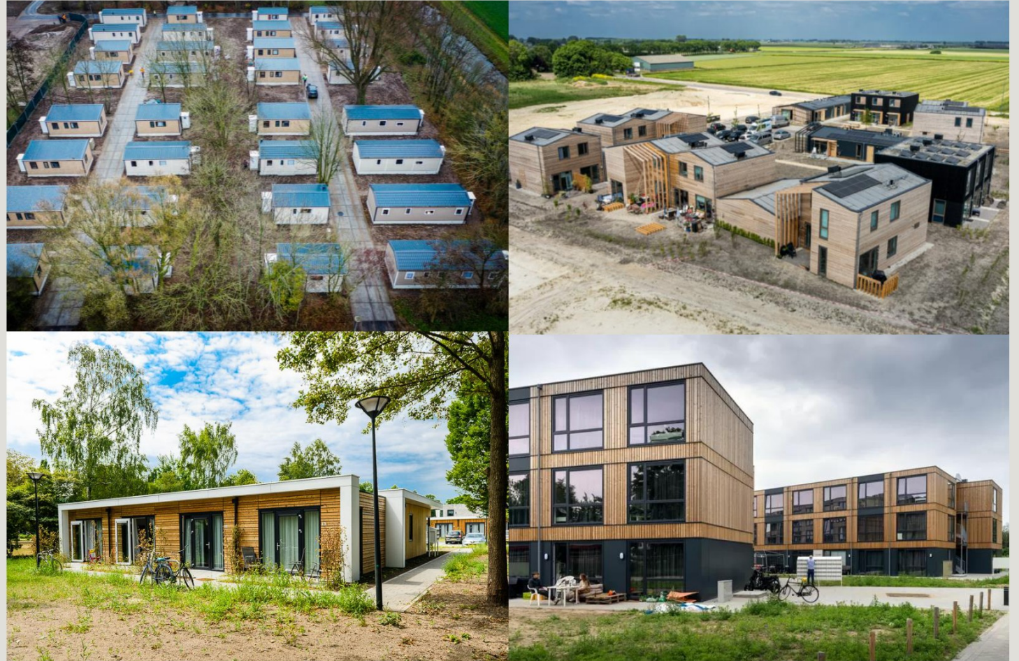
Voorbeeldprojecten v.l.n.r: chaletpark COA, modulaire prefab houtbouw STEK, tijdelijke (gestapelde) woonunits Barli.
